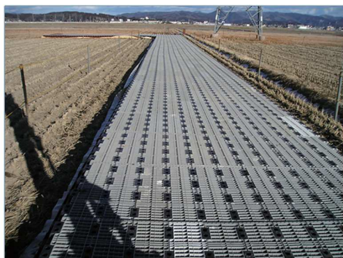
②スペーサーを敷設
