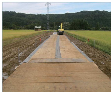
③上面に鉄板を敷設
