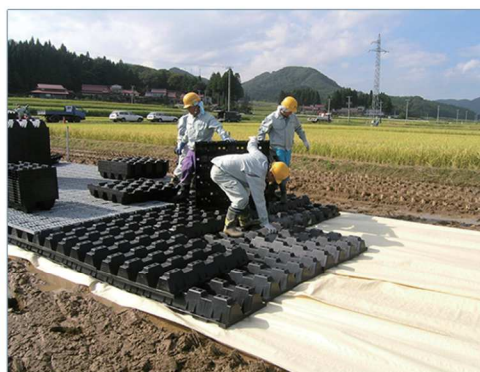
①プラロードを敷設
